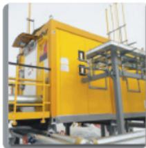
Автоматизированная газораспределительная станция (АГРС) для газоснабжения наливного терминала на ст. Коротчаево
